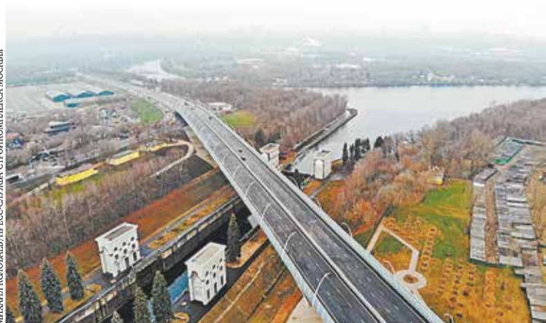
Новый Карамышевский мост — часть участка Северо-Западной хорды, генпроектировщиком которого является «Мосинжпроект»
