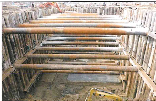
Фото 10: Распорные системы котлована из труб
