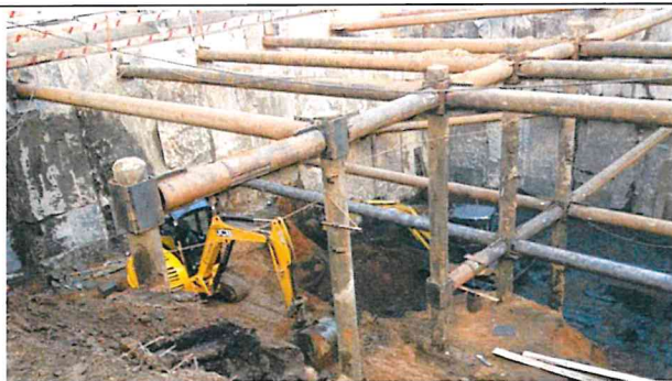
Фото 11: Распорные системы котлована из труб
