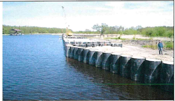
Фото 4: Трубопункт, использованный для устройства береговой линии
