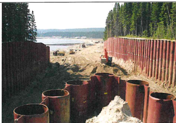
Фото 7: Трубошпунт, использованный для благоустройства территории и берегоукрепления
